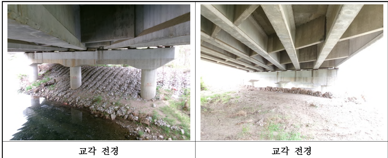
【사진 1.3.10】 교각 전경
