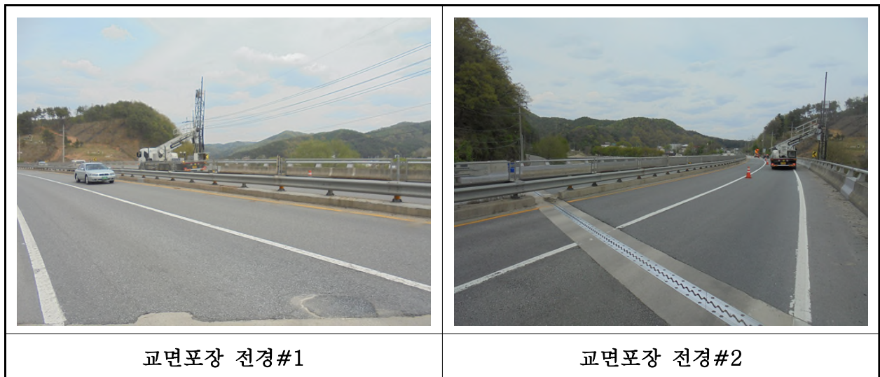
【사진 1.3.19】 교면포장 전경
