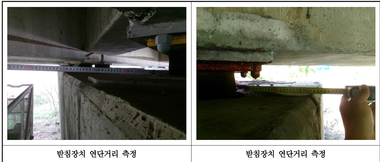
【사진 1.3.14】 교량받침장치 연단거리측정
