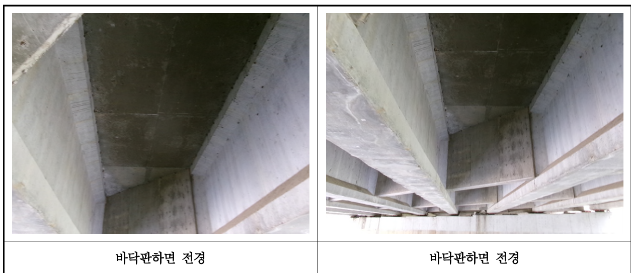
【사진 1.3.2】 바닥판하면 전경
