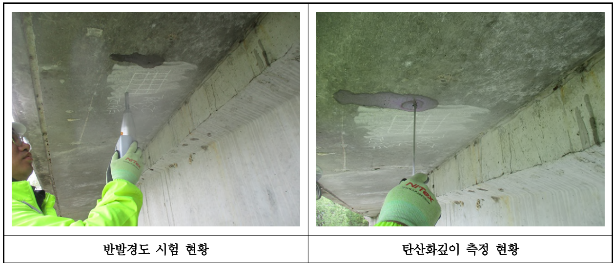
【사진 1.4.1】 콘크리트 내구성조사 현황
