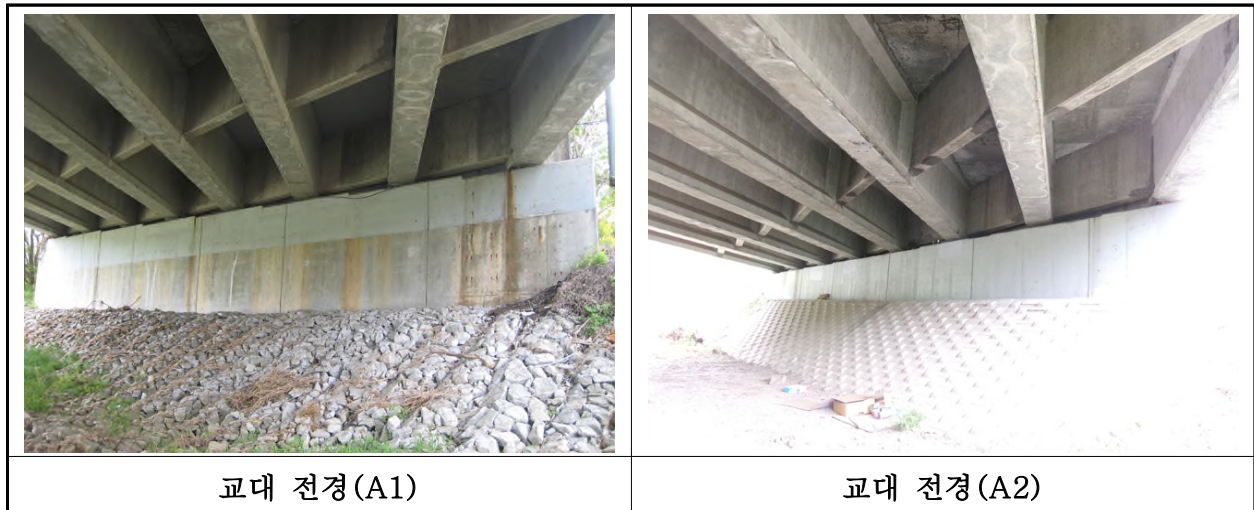
【사진 1.3.8】 교대 전경
