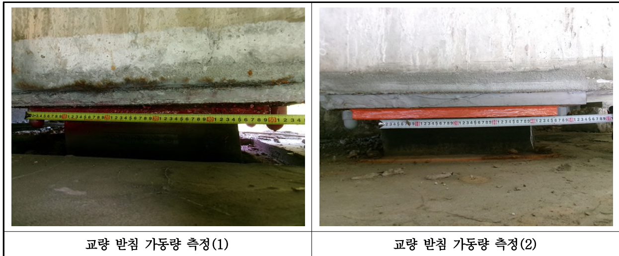
【사진 1.3.15】교량받침 이동량 측정
