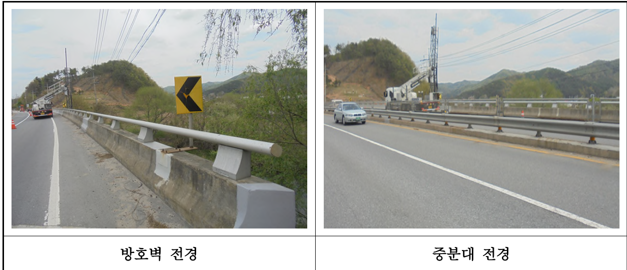
【사진 1.3.23】 방호벽 및 중앙분리대 전경
